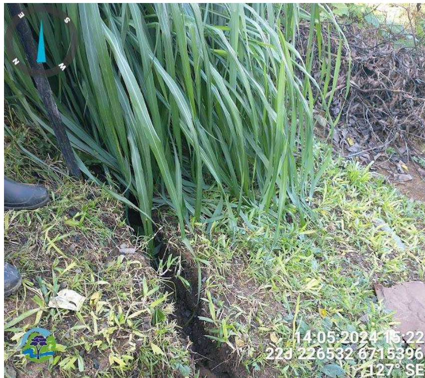
Figura 3 - Rachadura na região da crista do escorregamento.
