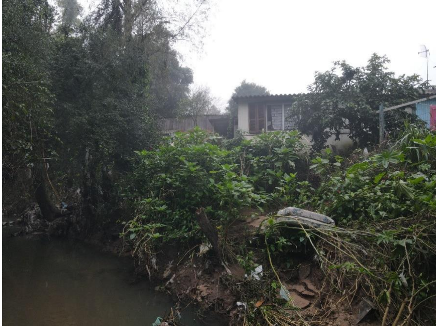
Figura 38. Processo erosivo ativo na margem de aterro, primeira moradia do setor de jusante para montante.
