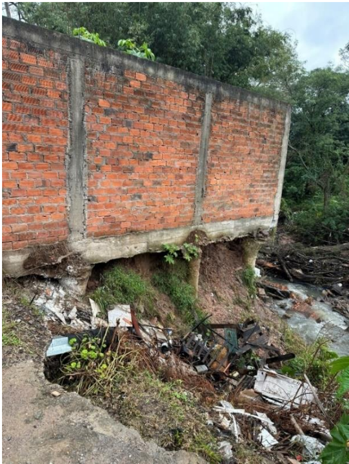
Figura 29. Vista parcial do Setor 01, processo de erosão de margem próximo à Rodovia BR287.
