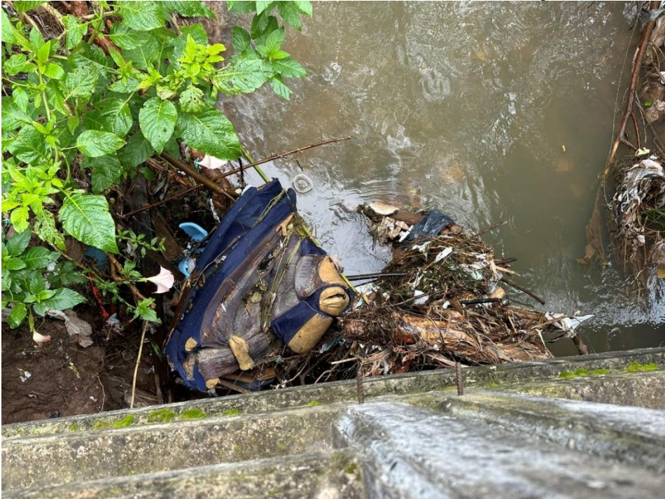
Figura 68. Vista parcial do Setor 13. Vista de cima de bueiro obstruído por lixo, galhos de árvores e entulho.
