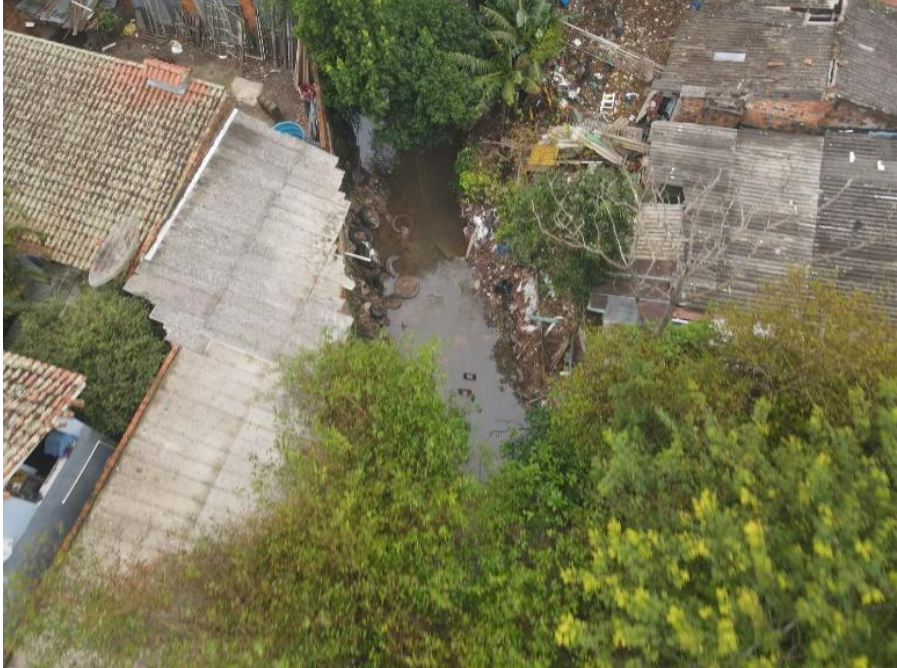
Figura 47. Processo erosivo ativo na margem de aterro, primeira moradia do setor de montante para jusante.
