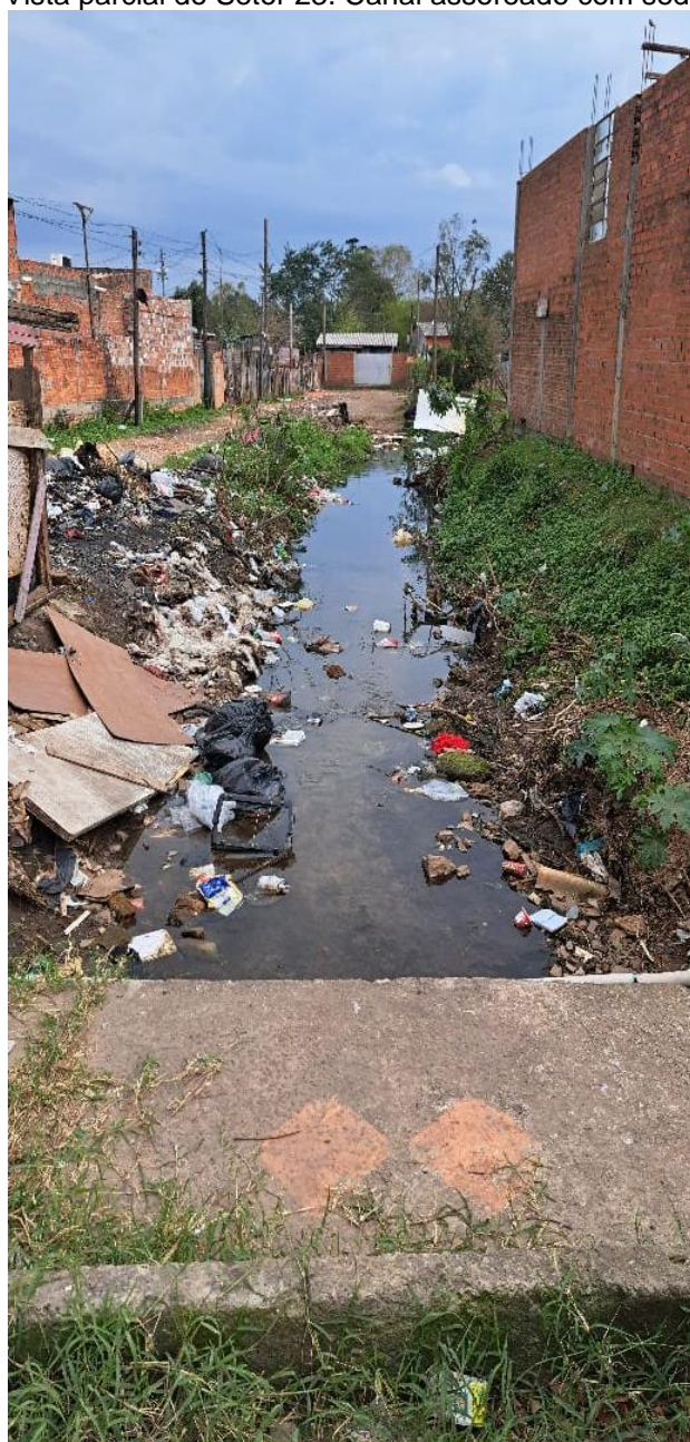
Figura 30 – Vista parcial do Setor 23. Canal assoreado com sedimento e lixo.
