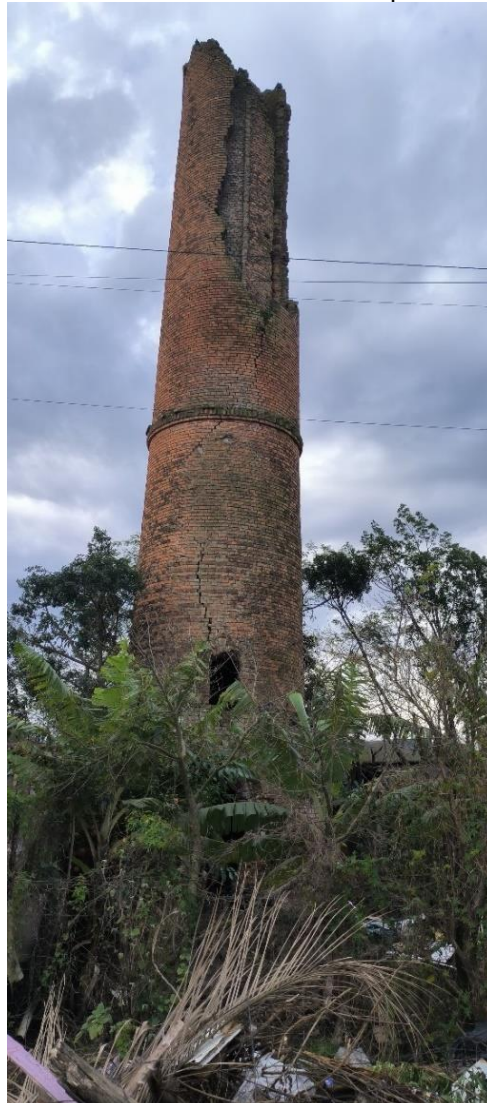
Figura 73 - Detalhe da Chaminé onde se vê o comprometimento da estrutura.
