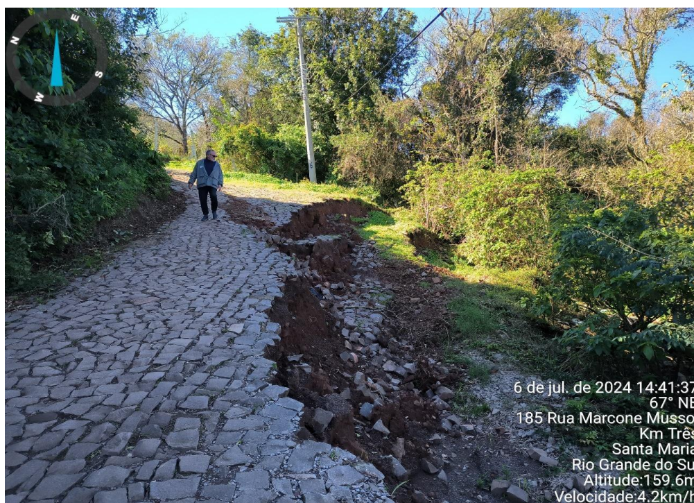
Foto 06 - Trincas e escorregamento que atingiram a rua de acesso a comunidade.
