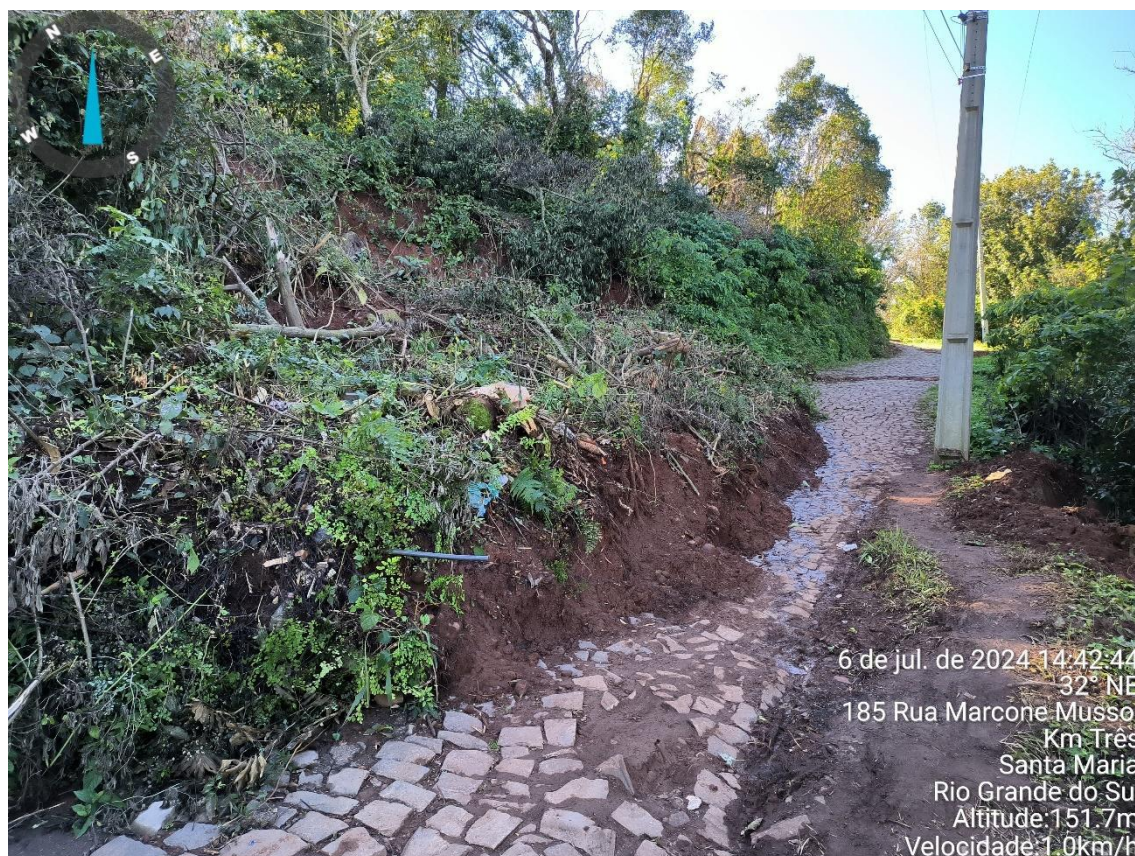
Figura 05 - Escorregamento na encosta entre primeiro e segundo patamar com interdição da estrada de acesso à comunidade.
