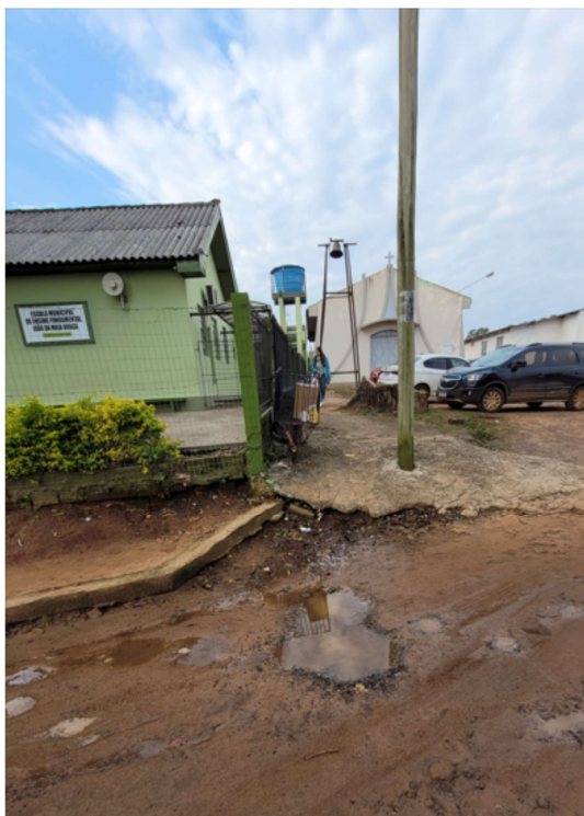
Figuras 1 e 2 – Calçada lateral e caixa de inspeção com vazamentos (05/06/2024)
