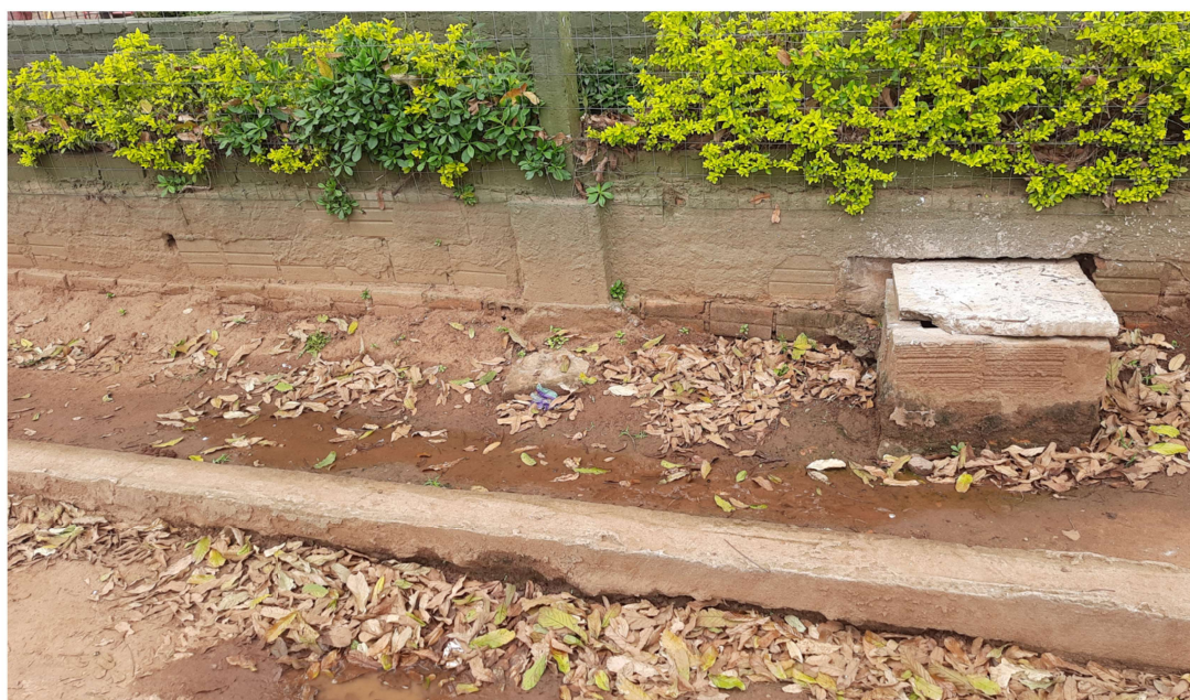
Figura 6 – Caixa de inspeção com vazamento (18/10/2024)
