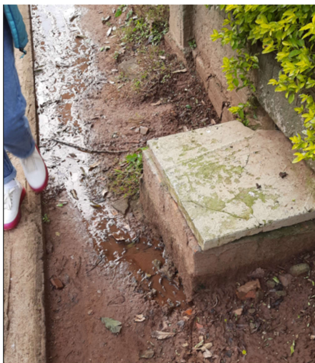
Figuras 1 e 2 – Calçada lateral e caixa de inspeção com vazamentos (05/06/2024)
