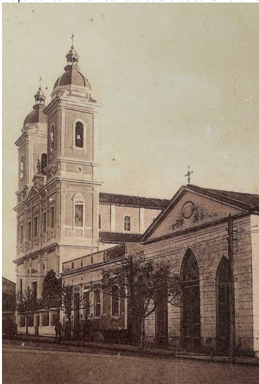
Figura 26 - Vista da Igreja do Divino em primeiro plano, que atendeu a comunidade católica entre a demolição da antiga matriz e a finalização da nova. Em segundo plano, a Catedral. Fonte: acervo do Museu Sacro de Santa Maria, citado por Bisognin e Coelho, 2009.
