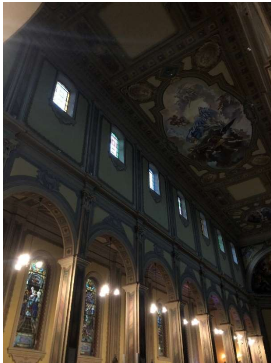
Figura 18 – Vista da arcada de comunicação entre a nave principal e a nave lateral esquerda da catedral, onde é possível perceber o sistema de ventilação de janelas altas. Fonte: Jéssica Corsini, 2020.
