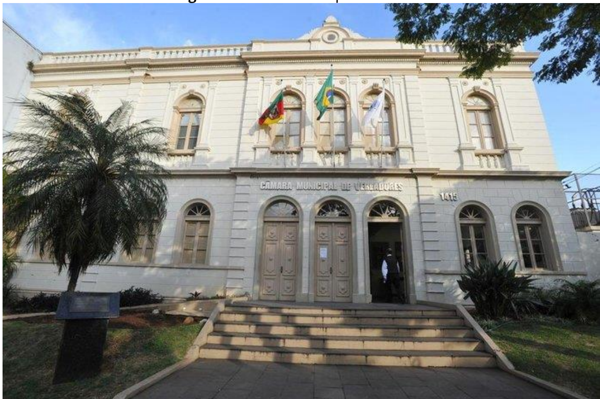
Figura 18: Fachada Principal da CMVSM
