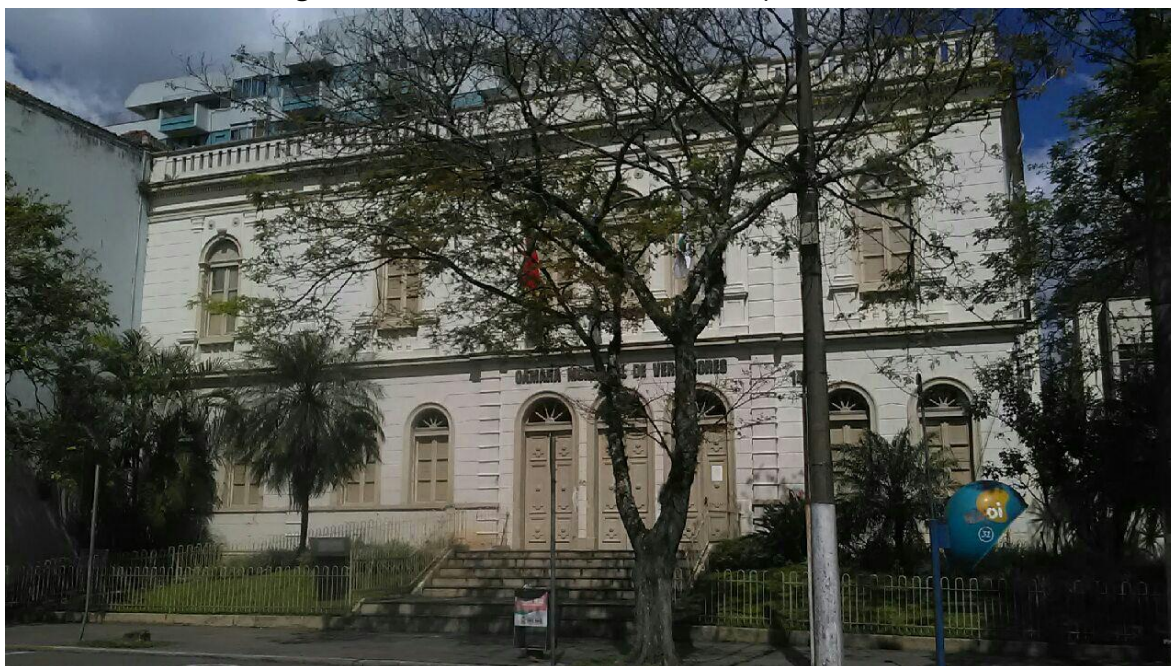
Figura 02: Fachada Norte da Câmara Municipal de Santa Maria.
