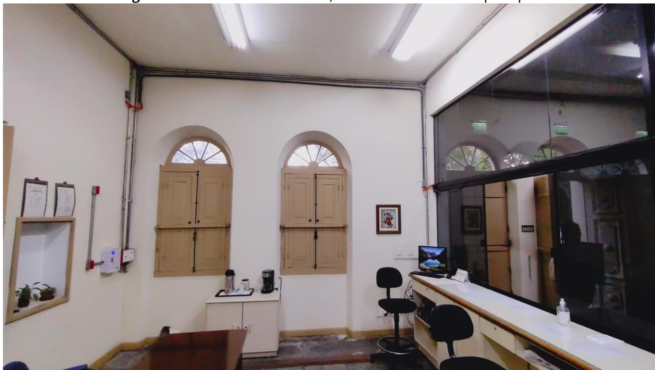
Figura 21: Hall de entrada CMVSM, vista interna da fachada principal.
