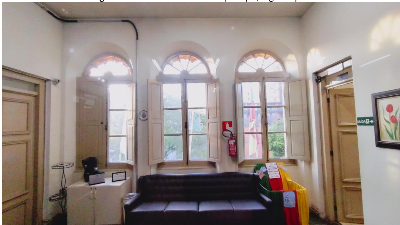
Figura 22: Vista interna da fachada principal, segundo pav.
