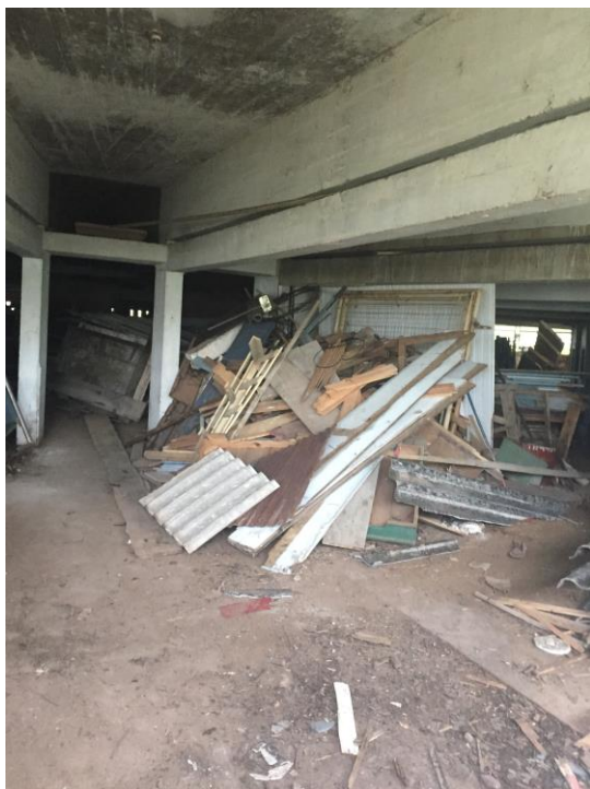
Figura 34 Pavimento inferior visto a partir do único acesso liberado atualmente. Fonte: Acervo ArqConjunta (2017).
