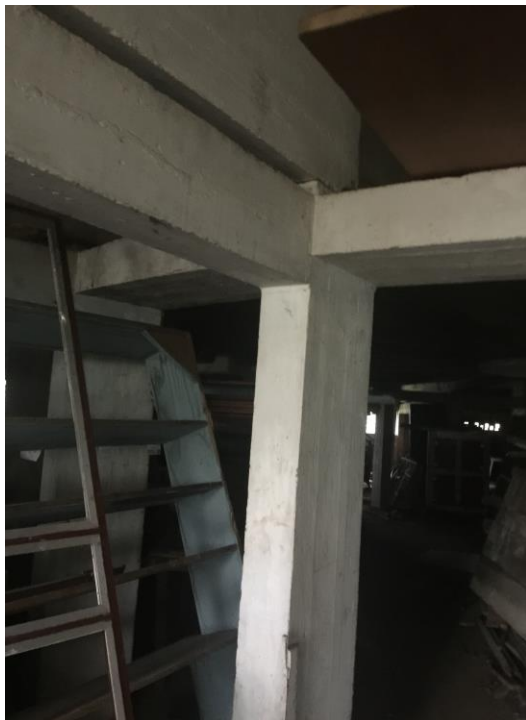
Figura 37 Estrutura (pilares e vigas) em concreto armado. É possível perceber os aparelhos de neoprene. Fonte: Acervo ArqConjunta (2017).
