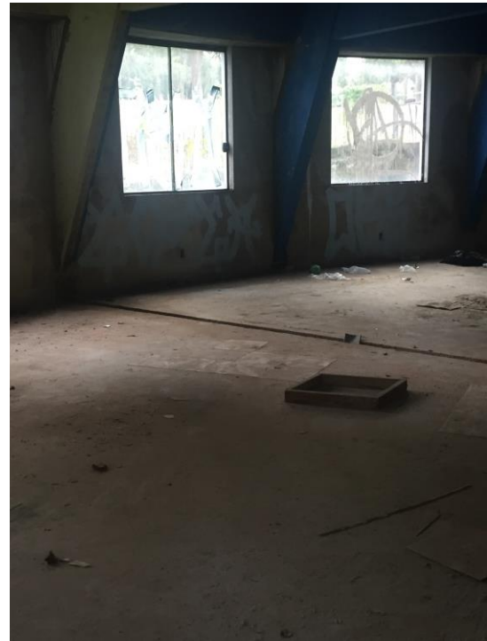
Figura 30 Paredes externas de vedação modificadas. Fonte: Acervo ArqConjunta (2017).
