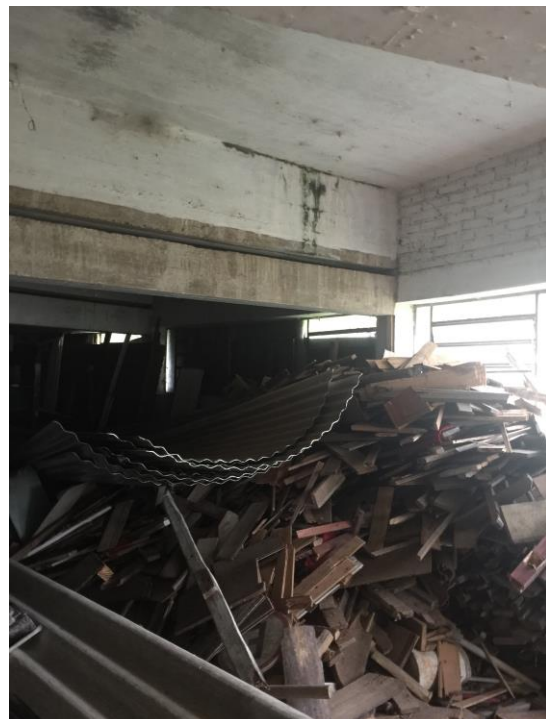
Figura 38 Vigamento em concreto armado com funcionamento estrutural independente. Fonte: Acervo ArqConjunta (2017).
