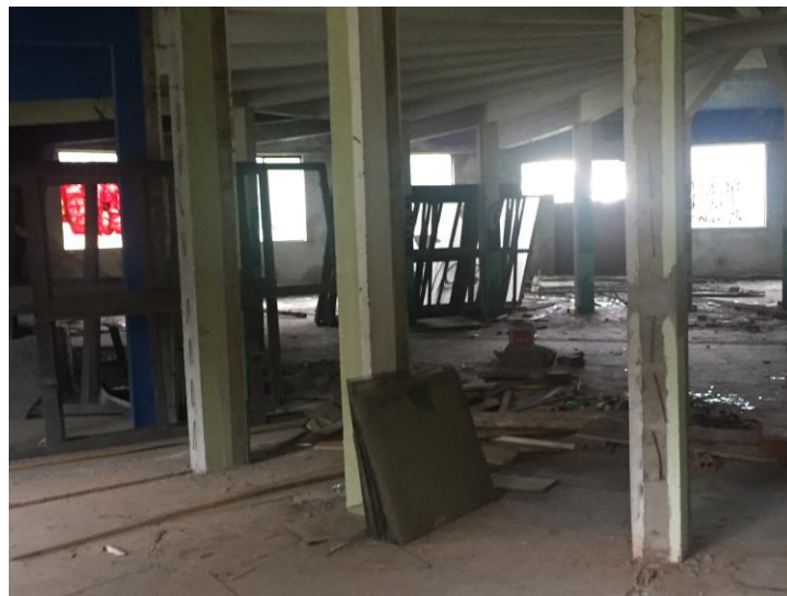
Figura 28 Pavimento Intermediário estruturado concentricamente (pilares e vigas) com miolo central livre. Fonte: Acervo ArqConjunta (2017).
