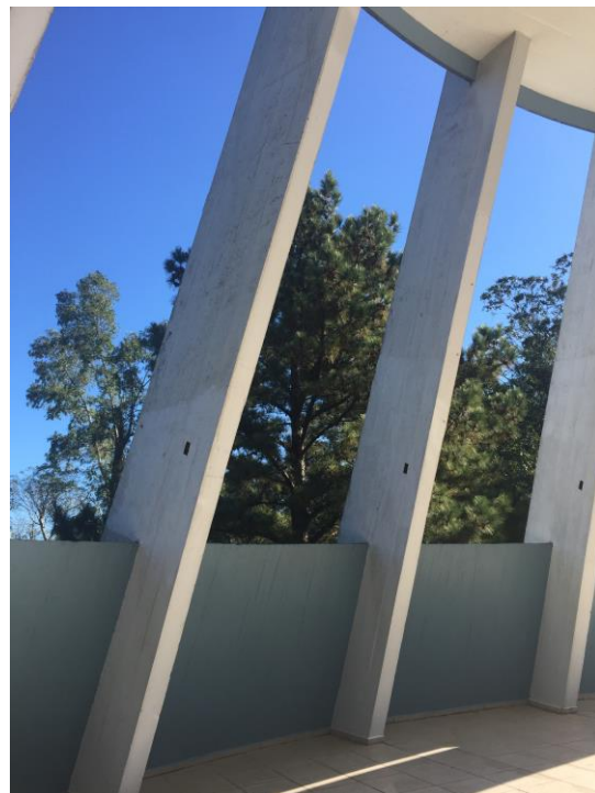
Figura 25 Paredes em concreto armado (marcação das formas); pilares inclinados com esperas elétrica. Fonte: Acervo ArqConjunta (2017).
