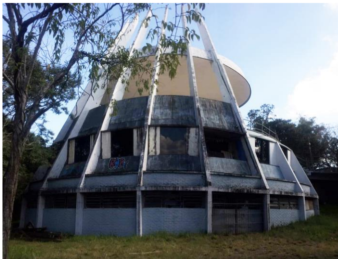
Figura 15 Fachada Nordeste (lateral) – Pavimento Intermediário com compartimentações e esquadrias descaracterizadas. Pavimento Inferior semienterrado. Fonte: Acervo ArqConjunta (2017).
