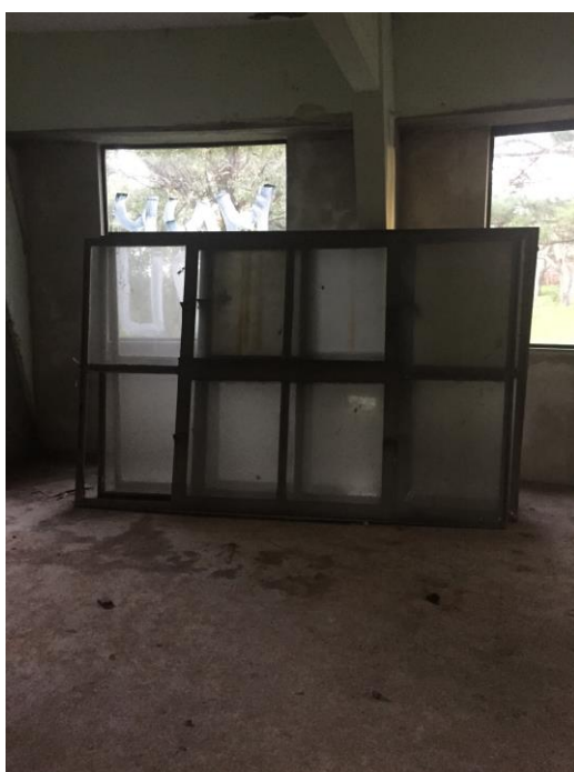
Figura 43 Esquadrias originais removidas permanecem no interior. Fonte: Acervo ArqConjunta (2017).
