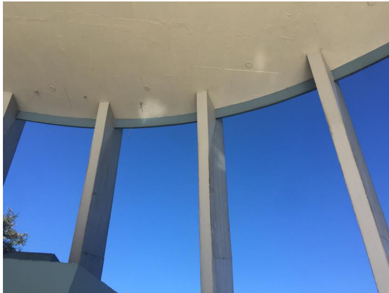
Figura 23 Laje dupla de forro em concreto armado, com esperas para elétrica situadas perifericamente. Fonte: Acervo ArqConjunta (2017)
