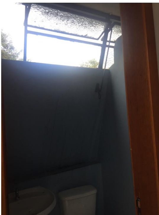
Figura 21 Banheiro localizado no pavimento térreo. Fonte: Acervo ArqConjunta (2017).
