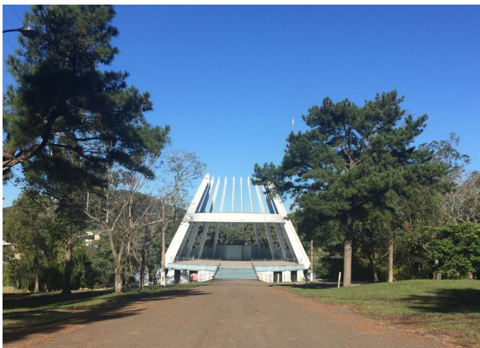
Figura 2 Fachada Noroeste – acesso. Fonte: : Acervo ArqConjunta (2017).
