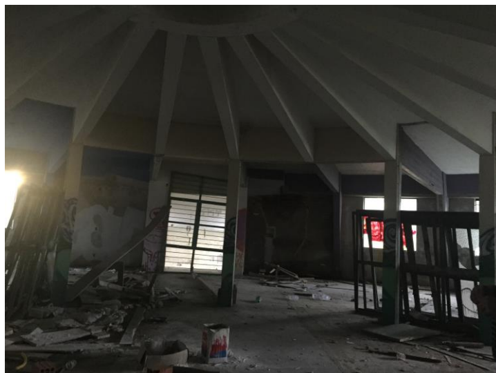
Figura 33 Parte central do pavimento intermediário. Sistema estrutural concêntrico. Fonte: Acervo ArqConjunta (2017).
