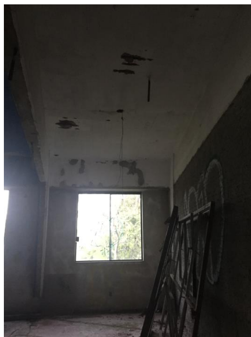
Figura 42 Esquadria em alumínio e vidro temperado, base da parede alterada. Fonte: Acervo ArqConjunta (2017).
