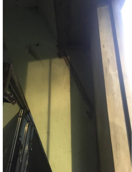
Figura 60 Marca interna, disposta lateralmente aos pilares inclinados, da esquadria original. Fonte: Acervo ArqConjunta (2017)
