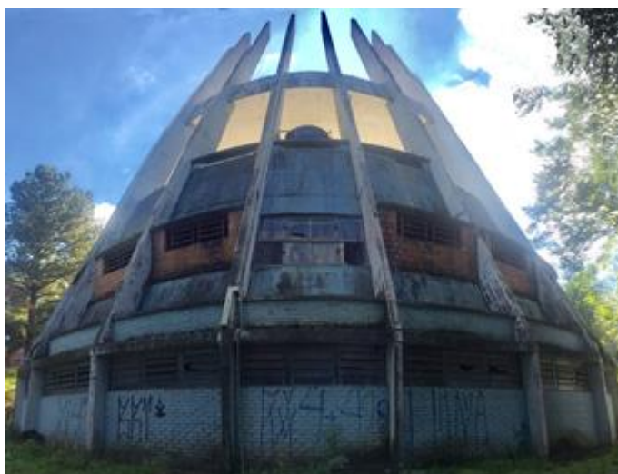
Figura 16 Fachada Sudeste (fundos) – Pavimento Intermediário permanece com esquadria original posicionada no Eixo Central. Fonte: Acervo ArqConjunta (2017).
