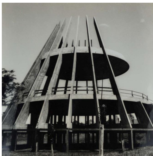
Figura 2 Altar em construção.
