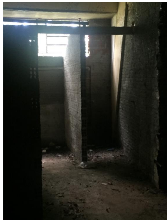
Figura 32 Locação dos sanitários, paredes em tijolos 6 furos chapiscadas, início de instalações hidrossanitárias. Fonte: Acervo ArqConjunta (2017).
