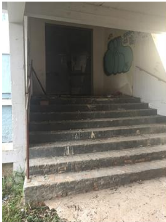
Figura 18 Acesso ao Pavimento Intermediário situado sob a passarela de acesso principal. Fonte: Acervo ArqConjunta (2017).
