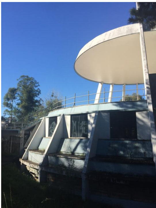
Figura 41 Estrutura principal porticada. Nota-se o grande balanço da laje de cobertura. Fonte: Acervo ArqConjunta (2017).
