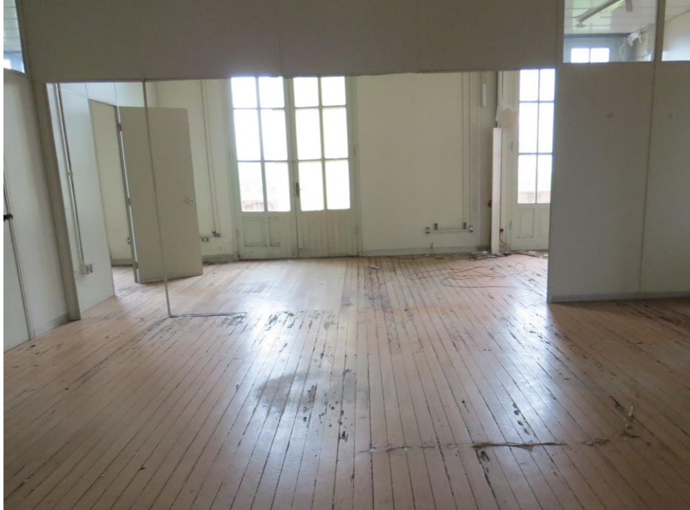
Figura 52: Interior da edificação – 3º pavimento. Fonte: NOGUEIRA (2021)
