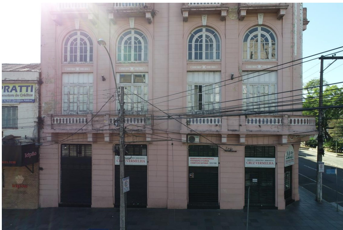
Figura 26: Fachada oeste. Fonte: Grão Studio (2021)
