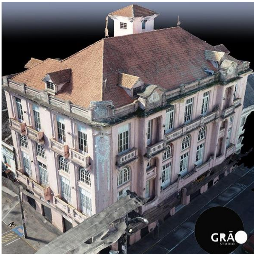
Figura 56: Fachadas da edificação. Fonte: Grão Studio (2021)
