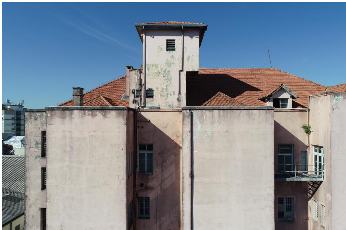
Figura 30: Fachada norte. Fonte: Grão Studio (2021)
