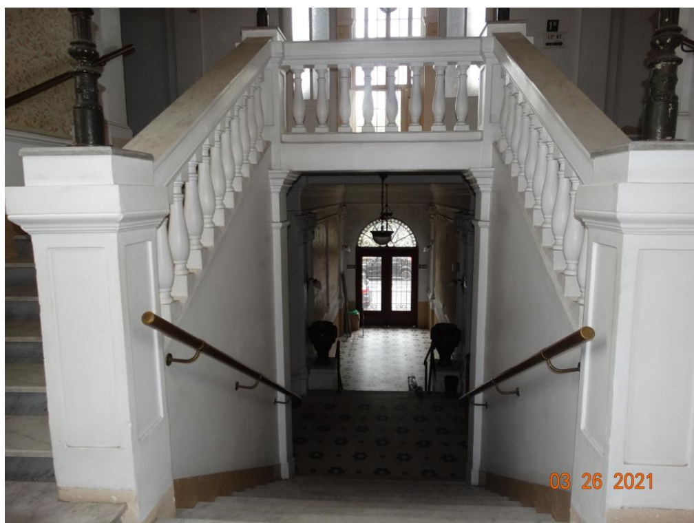
Figura 43: Interior da edificação – patamar da escada principal. Fonte: NOGUEIRA (2021)
