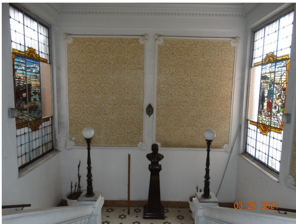
Figura 44: Interior da edificação – patamar da escada principal. Fonte: NOGUEIRA (2021)
