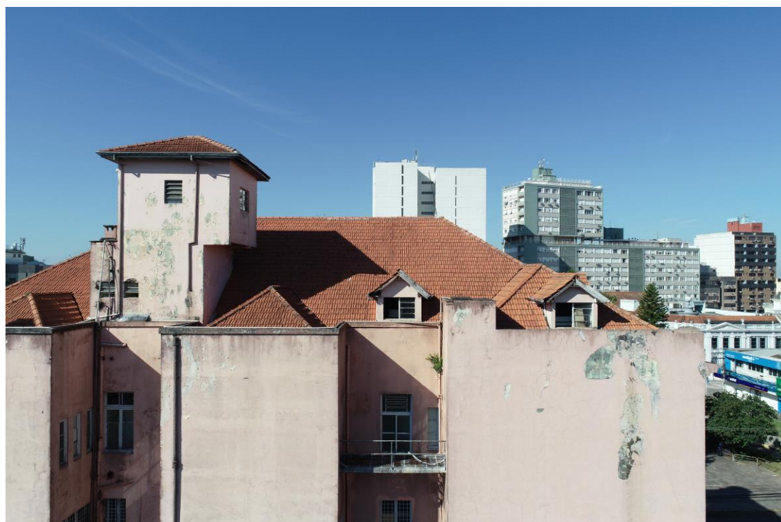
Figura 31: Fachada oeste. Fonte: Grão Studio (2021)
