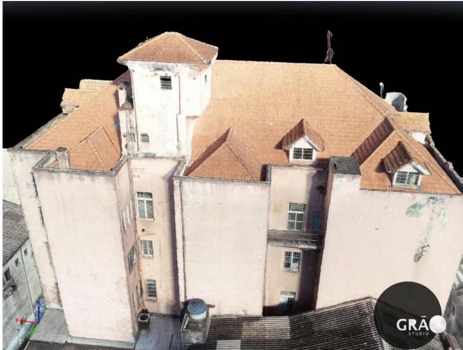
Figura 60: Fachadas da edificação. Fonte: Grão Studio (2021)
