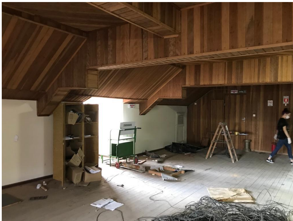
Figura 54: Interior da edificação – 4º pavimento. Fonte: NOGUEIRA (2021)
