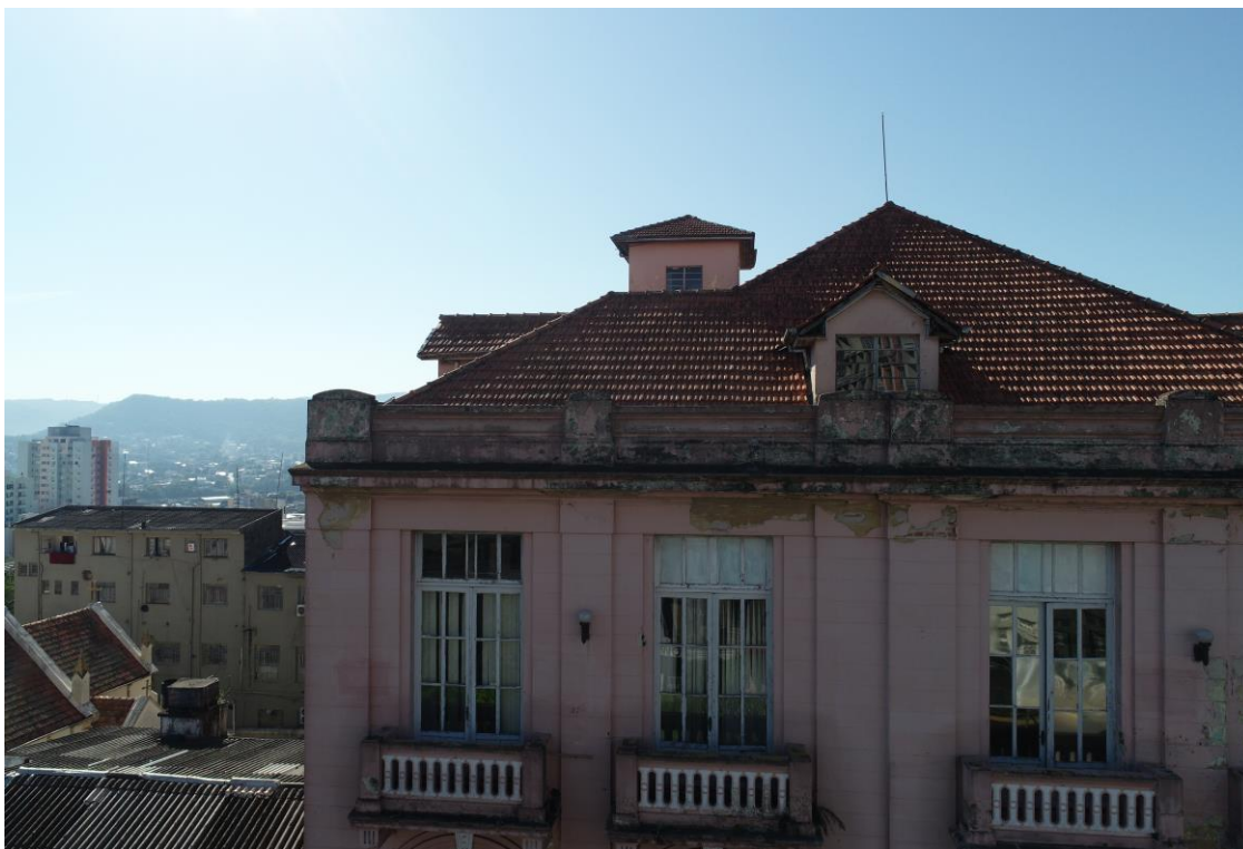
Figura 32: Fachada oeste. Fonte: Grão Studio (2021)
