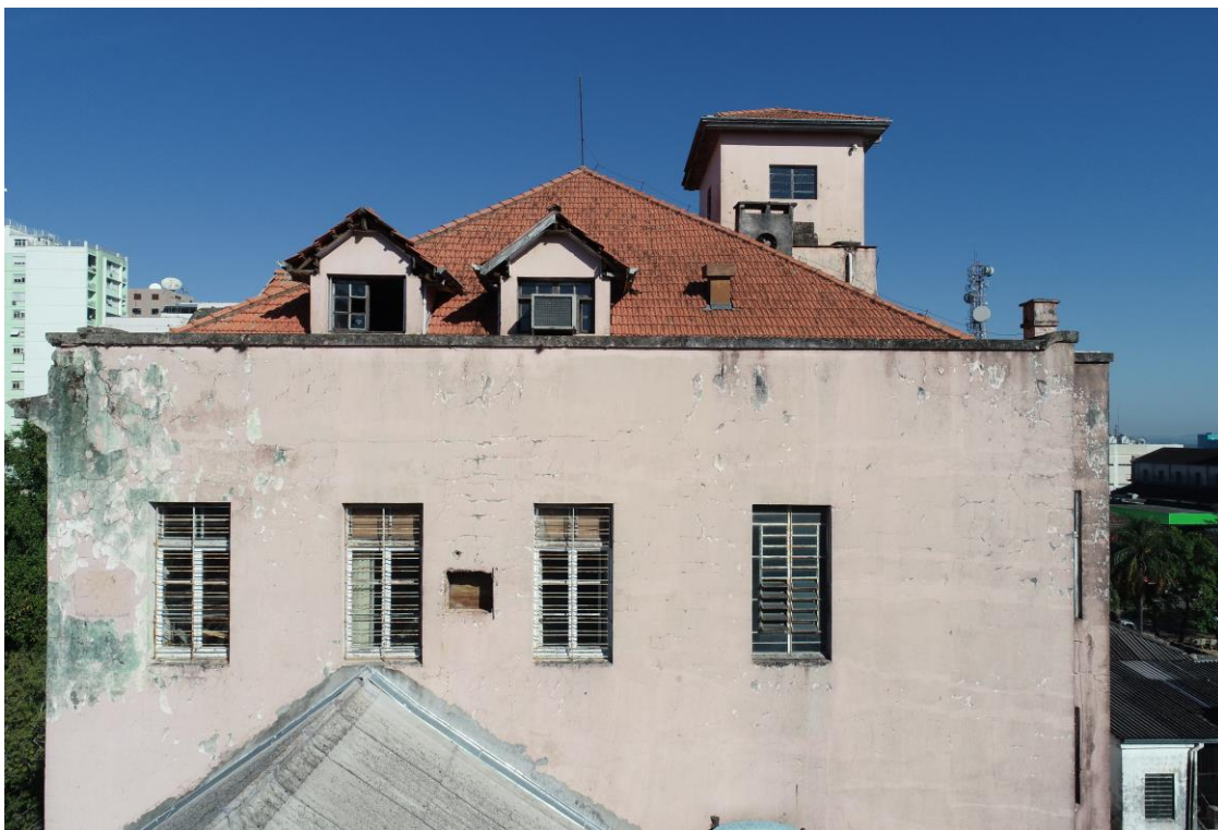
Figura 28: Fachada leste. Fonte: Grão Studio (2021)
