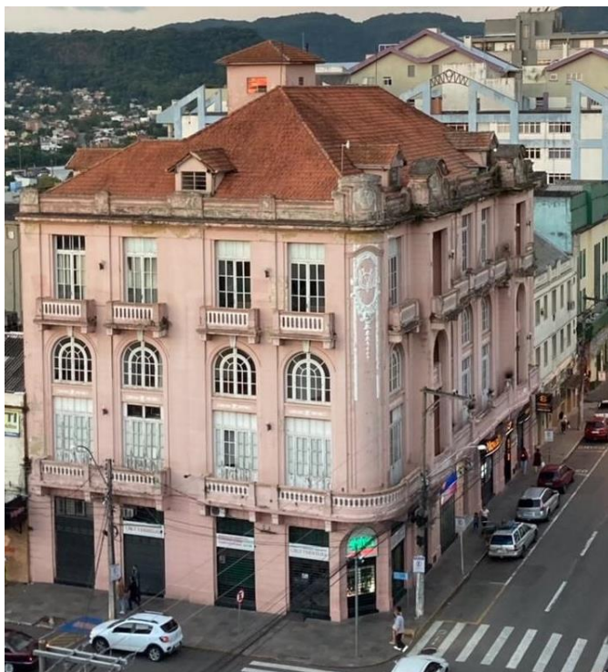
Figura 02: Fotografia da edificação.
