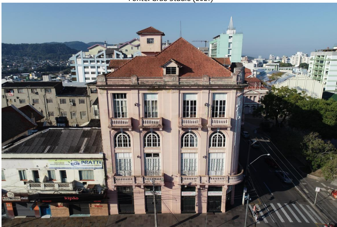
Figura 25: Fachada oeste. Fonte: Grão Studio (2021)
