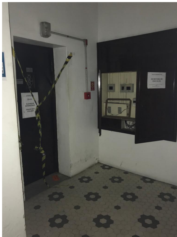
Figura 38: Interior da edificação – hall do térreo. Fonte: NOGUEIRA (2021)
