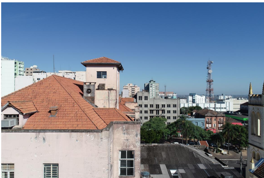
Figura 29: Fachada leste. Fonte: Grão Studio (2021)
