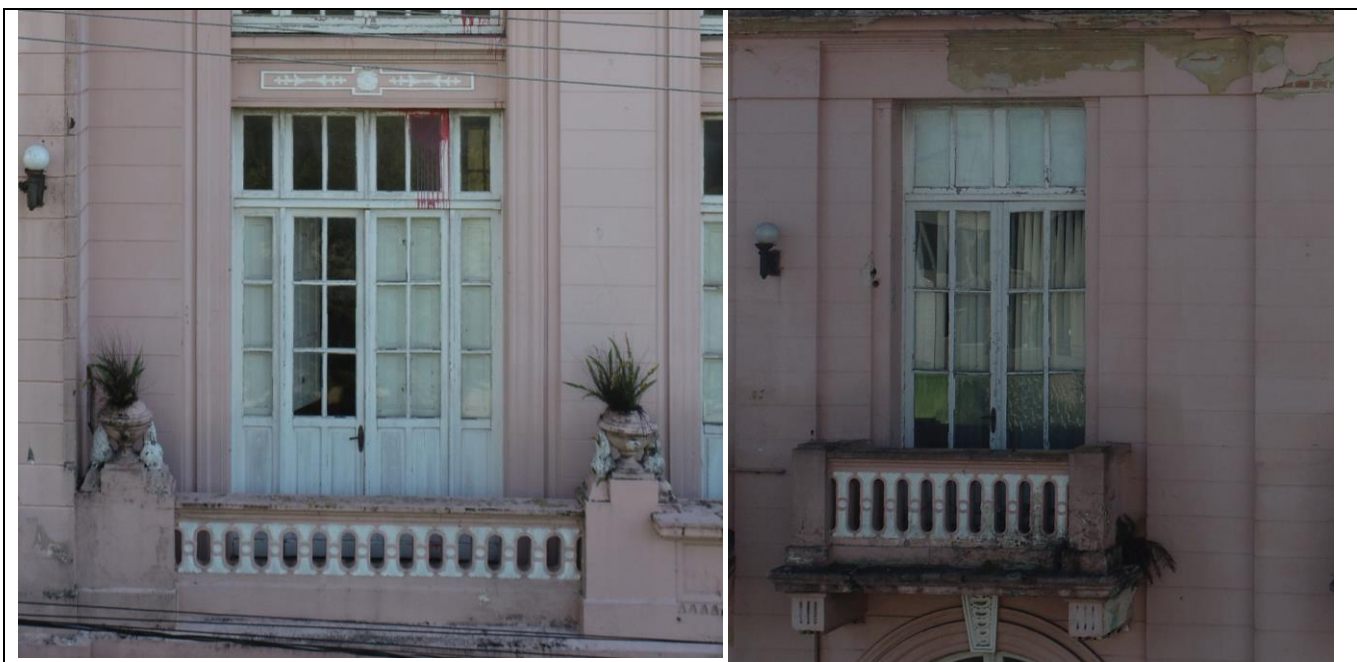
Figuras posição fachada sul A-B/4-6 e fachada oeste F-G/4-6
