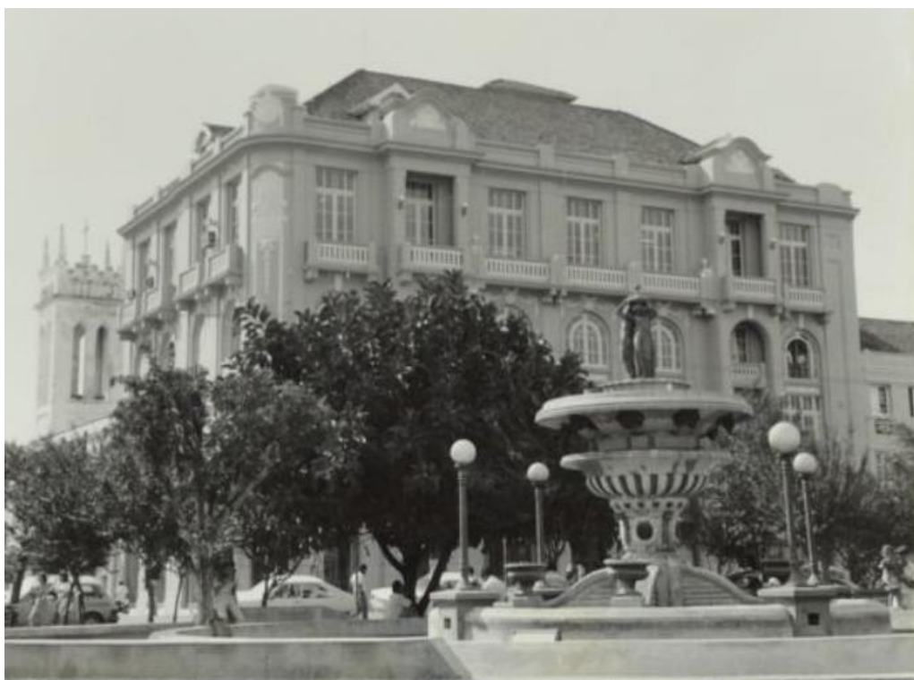
Figura 7: Edifício João Fontoura Borges. [s.d.]
