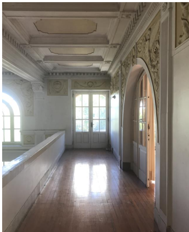
Figura 48: Interior da edificação – mezanino do 2º pavimento. Fonte: NOGUEIRA (2021)
