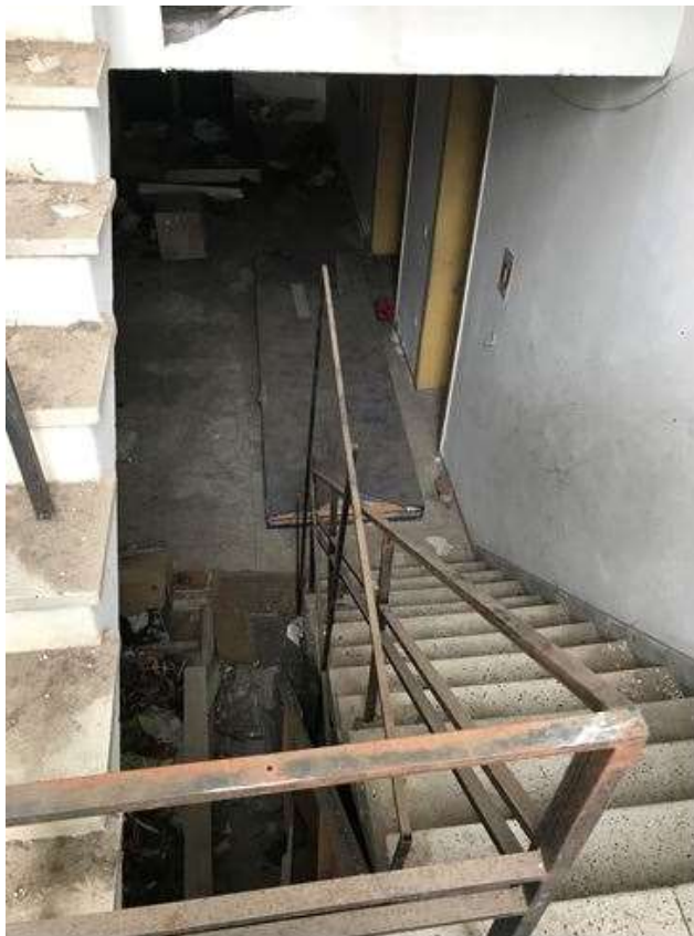
Figura 62: Escada que acessa o segundo pavimento, vista desde o patamar. Fonte: FROS, C.S (2022).
