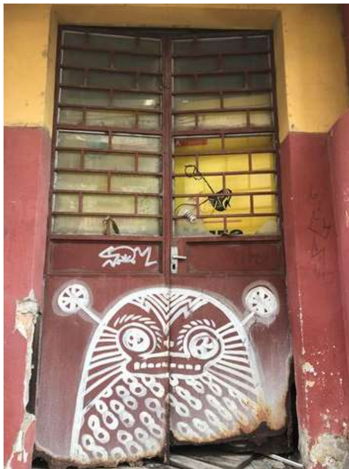
Figura 107: Porta metálica, correspondente ao acesso lateral, localizado na Rua Roque Callage – PE2. Fonte: FROS, C.S (2022).
