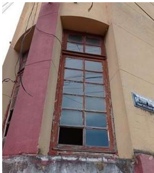
Figura 115: Janela JE2a, localizada no vértice da edificação – térreo. Fonte: SCHARLAU, M.L (2022).
