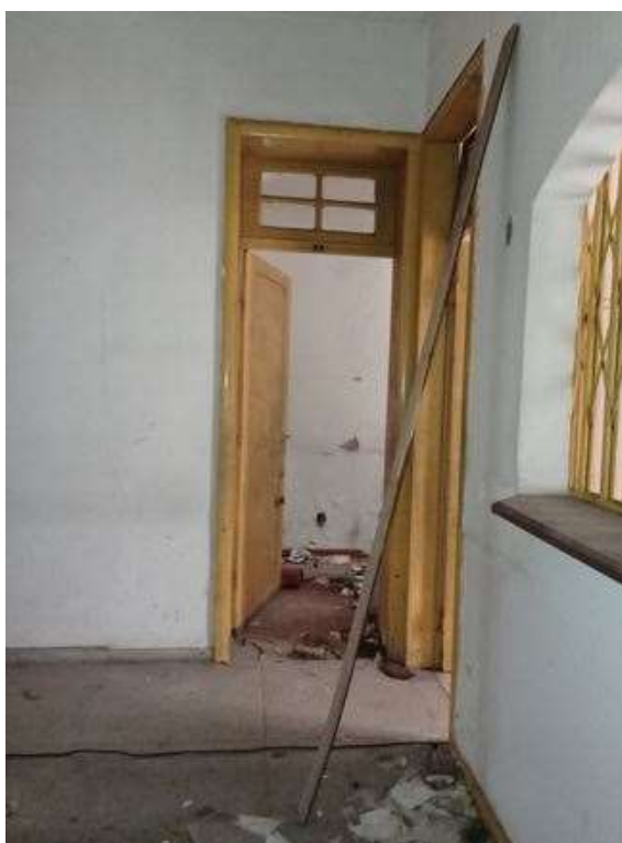
Figura 137: Porta PE18, localizada na circulação horizontal do primeiro pavimento. Fonte: SCHARLAU, M.L (2022).
