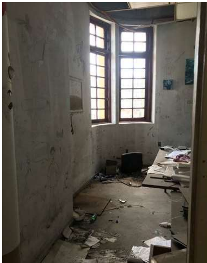
Figura 71: Esquadrias e ambiente localizado no vértice térreo da edificação, visto desde o ambiente lateral. Fonte: FROS, C.S (2022).
