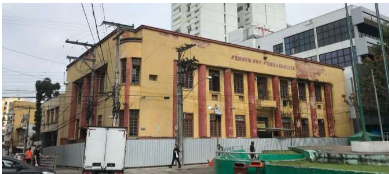
Figura 02: Fachadas Norte e Oeste do Antigo Fórum, conhecida atualmente como Casa de Cultura de Santa Maria. Fonte: FROS, C.S (2021)
