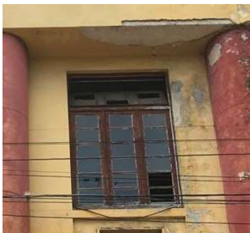
Figura 123: Janela de madeira com bandeirola, três folhas e caixilhos com vidro. Localizada no segundo pavimento. Código JE1k. Fonte: FROS, C.S (2022).
