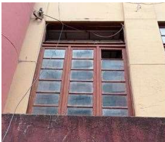
Figura 130: Janela JE6b, localizada na fachada voltada à Rua Roque Callage. Fonte: SCHARLAU, M.L (2022).
