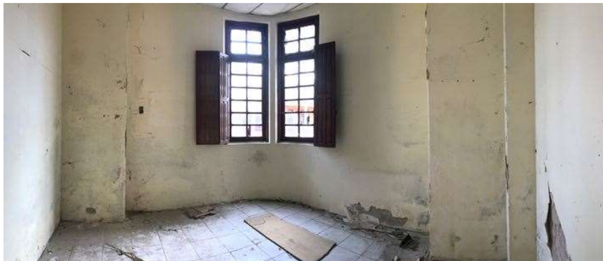
Figura 60: Vista interna das esquadrias e ambiente localizado no vértice térreo da edificação. Fonte: FROS, C.S (2022).
