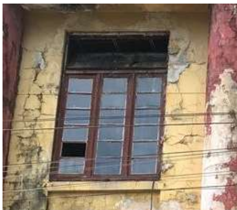
Figura 119: Janela de madeira com bandeiriola, três folhas e caixilhos com vidro. Localizada no segundo pavimento. Código JE1h. Fonte: FROS, C.S (2022).
