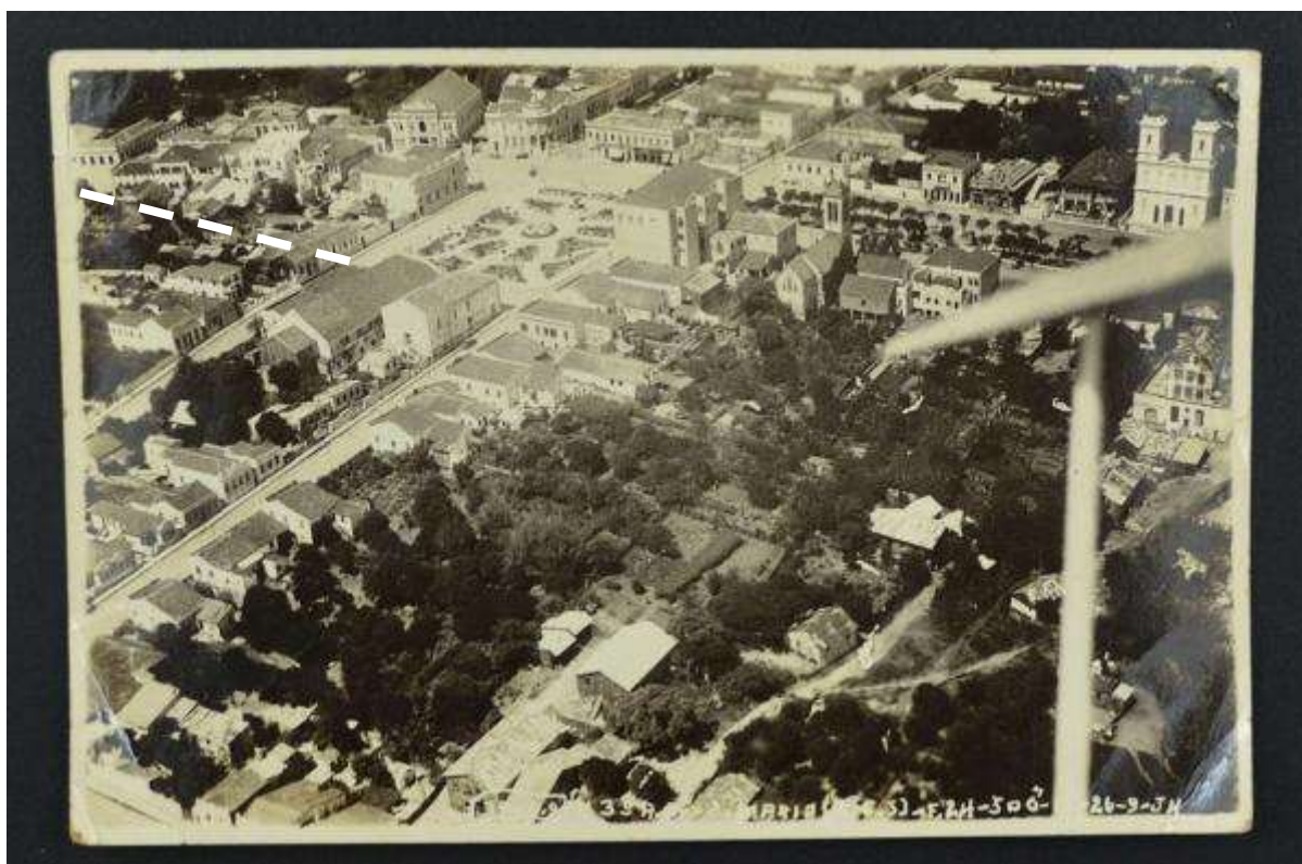
Figura 03: Foto aérea do centro da cidade. Grifo nosso.
