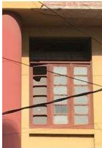
Figura 132: Janela JE5b, localizada no pavimento superior da fachada voltada à Rua Roque Callage. Fonte: FROS, C.S (2022).
