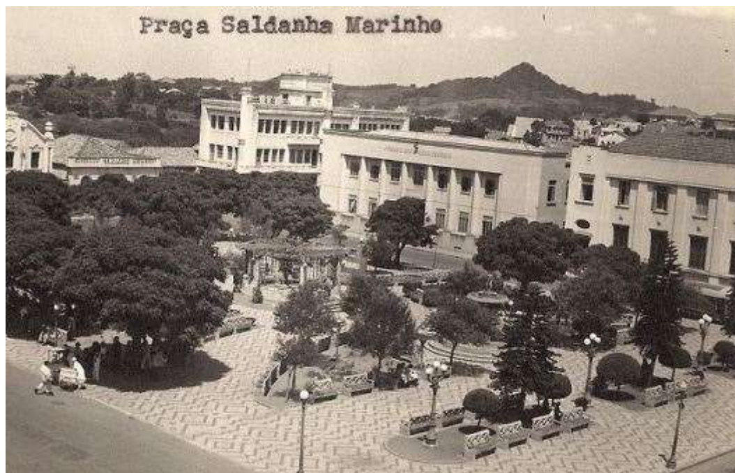
Figura 06: Foto que registra a construção do prédio concluído, década de 1940. Fonte: Frota, 2013 - Acervo de Marco Aurélio Biermann Pinto.
