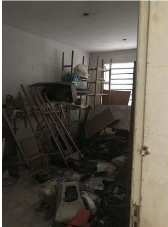
Figura 95: Ambiente no terceiro pavimento. Esquadria voltada aos fundos do lote. Fonte: FROS, C.S (2022).
