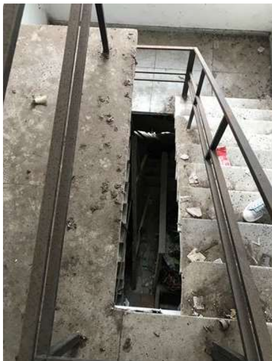
Figura 63: Desde o segundo pavimento, escada em direção ao térreo. Fonte: FROS, C.S (2022).
