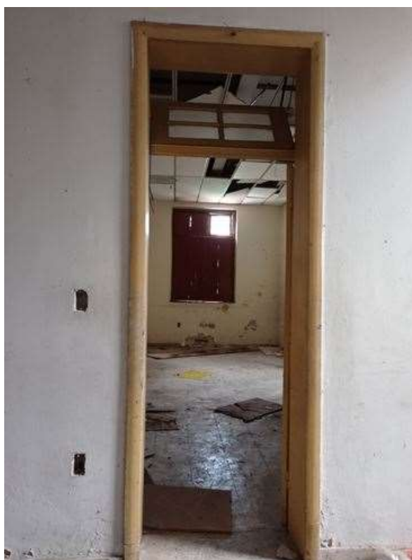
Figura 141: Porta PE5, localizada na circulação horizontal do primeiro pavimento. Fonte: SCHARLAU, M.L (2022).
