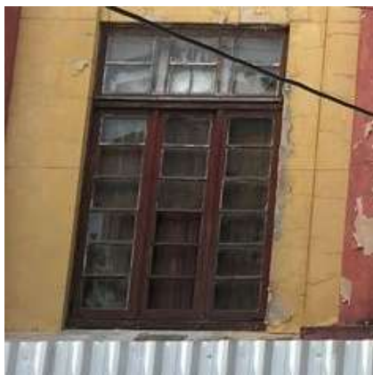
Figura 112: Janela de madeira com bandeira, três folhas e caixilhos com vidro. Identificada em desenho técnico como JE1d.
