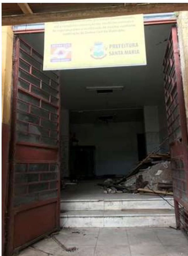
Figura 105: Porta metálica, e hall com piso e escadas de mármore – PE1. Fonte: FROS, C.S (2022).
