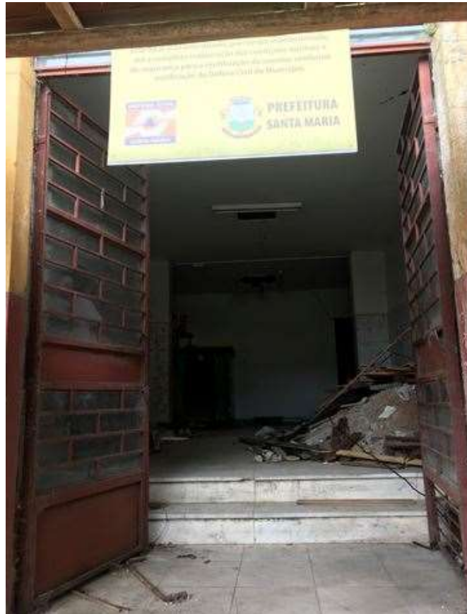
Figura 42: Porta de acesso à edificação. Fonte: FROS, C.S (2022).
