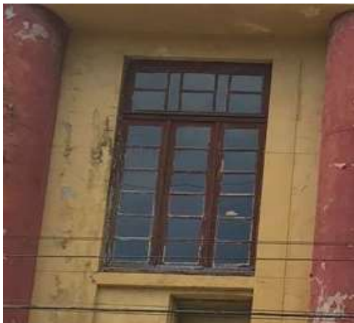
Figura 122: Janela de madeira com bandeirola, três folhas e caixilhos com vidro. Localizada no segundo pavimento. Código JE1j. Fonte: FROS, C.S (2022).
