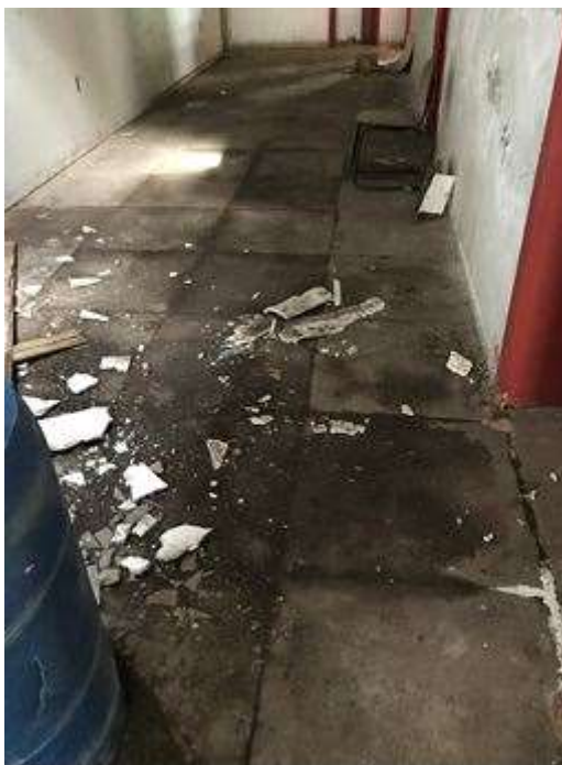
Figura 168: Microrganismos no piso de granitina presente na circulação horizontal do segundo pavimento. Fonte: FROS, C.S (2021).
