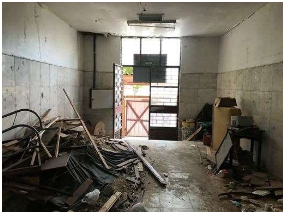
Figura 44: Hall de entrada, com paredes e piso revestidos de mármore. Fonte: FROS, C.S (2022).
