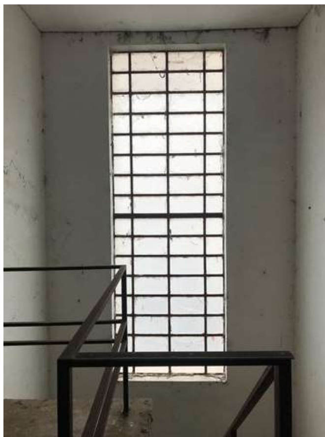
Figura 64: Esquadria metálica com vidros fixos. Identificado como vitral, o mesmo ilumina a escada. Fonte: FROS, C.S (2022).
