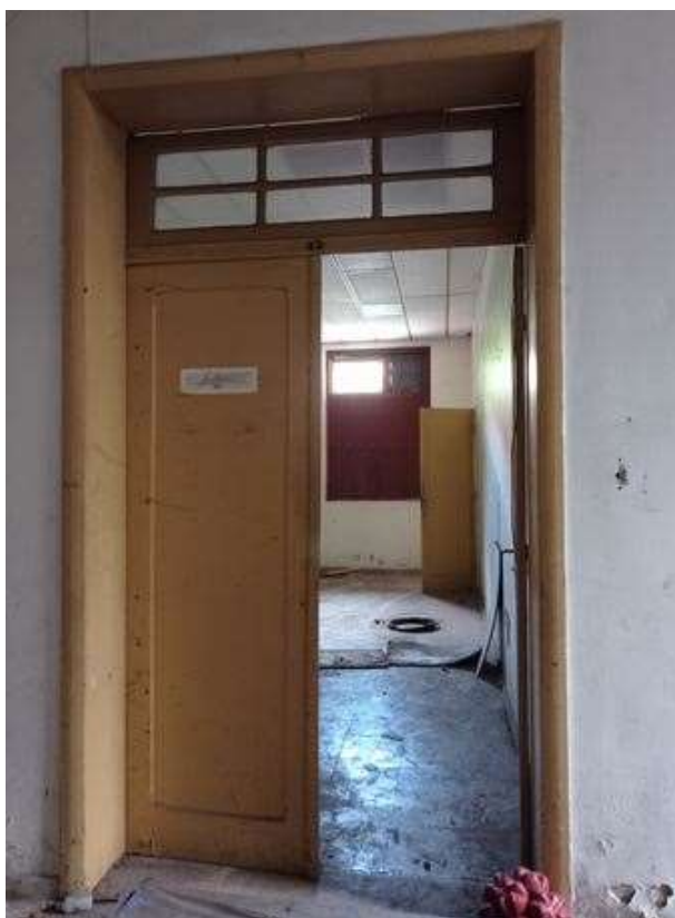
Figura 142: Porta PE4, localizada na circulação horizontal do primeiro pavimento. Fonte: SCHARLAU, M.L (2022).
