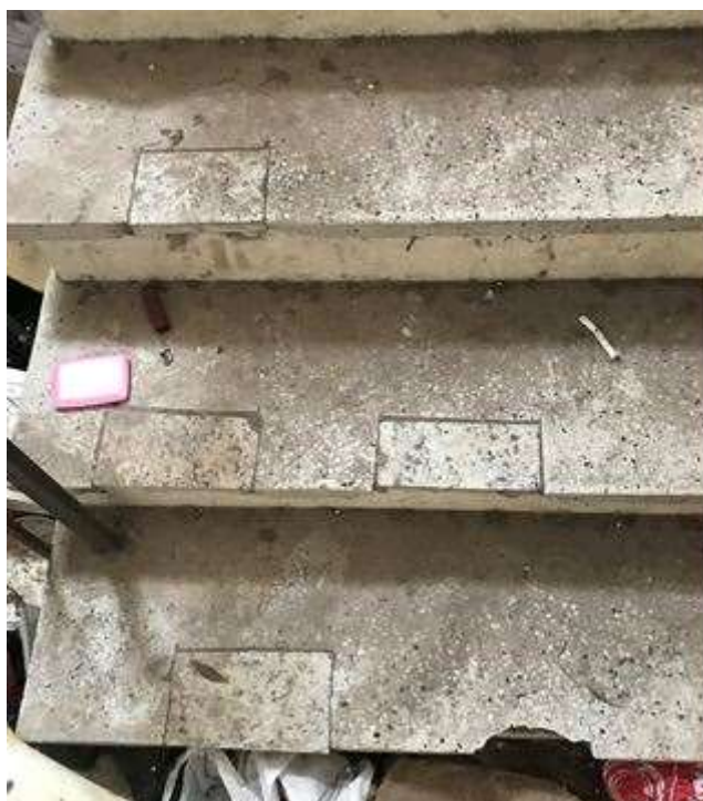
Figura 183: Escada que comunica o segundo pavimento com o terceiro e quarto pavimento. Há degraus de granitina com enxertos em granito. Fonte: FROS, C.S (2021).
