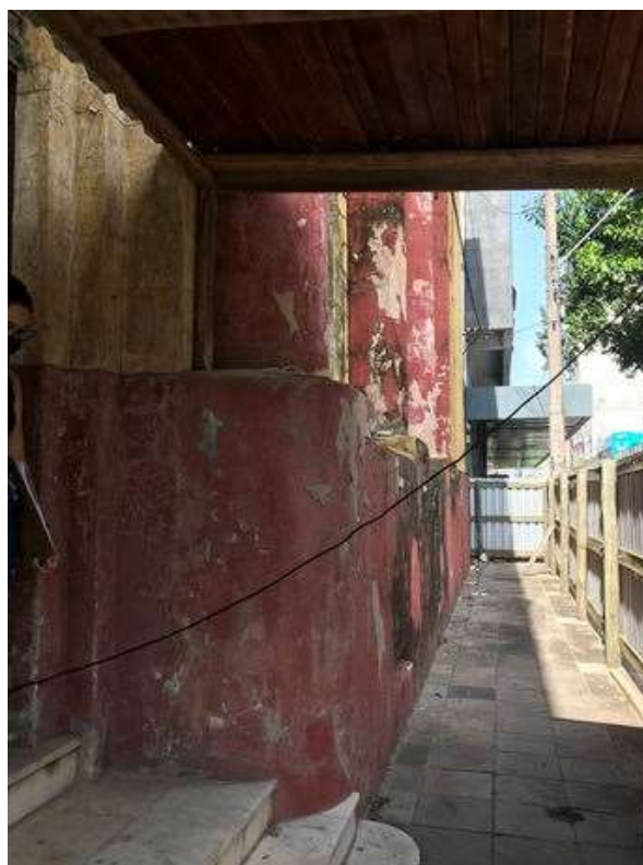
Figura 106: Volume saliente na base da edificação. Na imagem foi registrada parte da escada de acesso, assim como o vértice arredondado. Fonte: FROS, C.S (2022).
