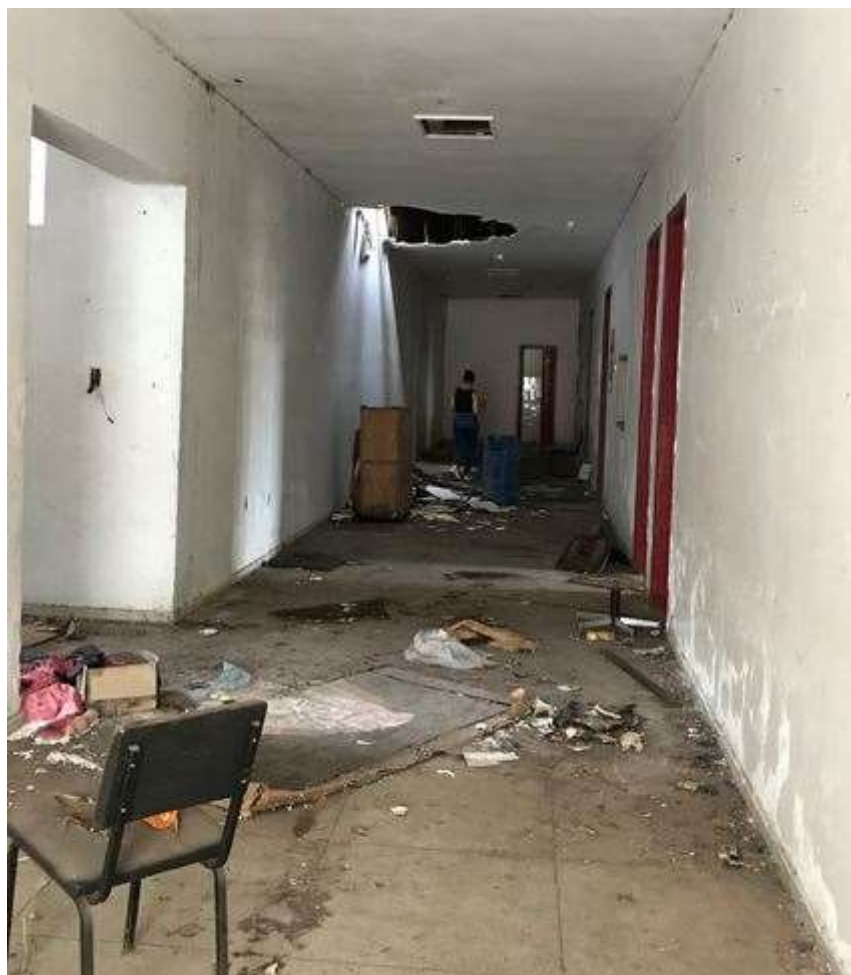
Figura 70: Corredor do segundo pavimento.
