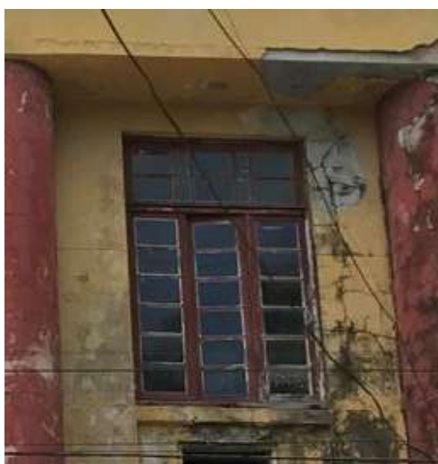
Figura 120: Janela de madeira com bandeiriola, três folhas e caixilhos com vidro. Localizada no segundo pavimento. Código JE1i. Fonte: FROS, C.S (2022).
