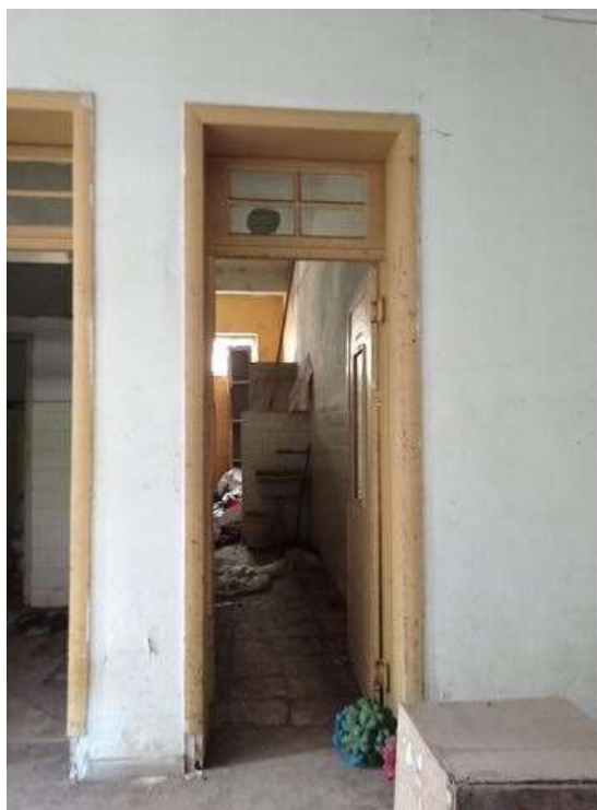
Figura 138: Porta PE6a, localizada na circulação horizontal do primeiro pavimento. Fonte: SCHARLAU, M.L (2022).
