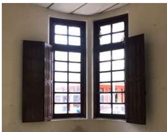
Figura 117: Vista interna das janelas JE2a e JE2b. Fonte: FROS, C.S (2022).
