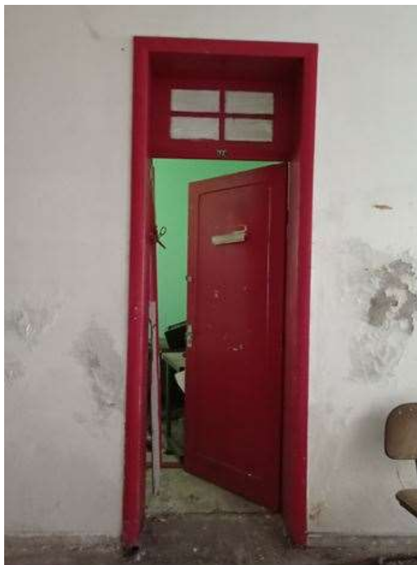
Figura 145: Porta PE3c, localizada na circulação horizontal do segundo pavimento. Fonte: SCHARLAU, M.L (2022).
