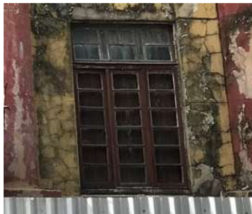
Figura 111: Janela de madeira com bandeirola, três folhas e caixilhos com vidro. Identificada em desenho técnico como JE1c. Fonte: FROS, C.S (2022).
