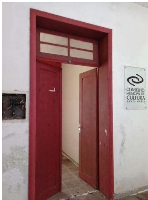
Figura 146: Porta PE8, localizada na circulação horizontal do segundo pavimento. Fonte: SCHARLAU, M.L (2022).
