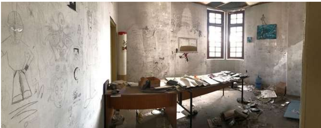
Figura 69: Vista interna do ambiente e das esquadrias, localizadas no vértice da edificação, no segundo pavimento.
