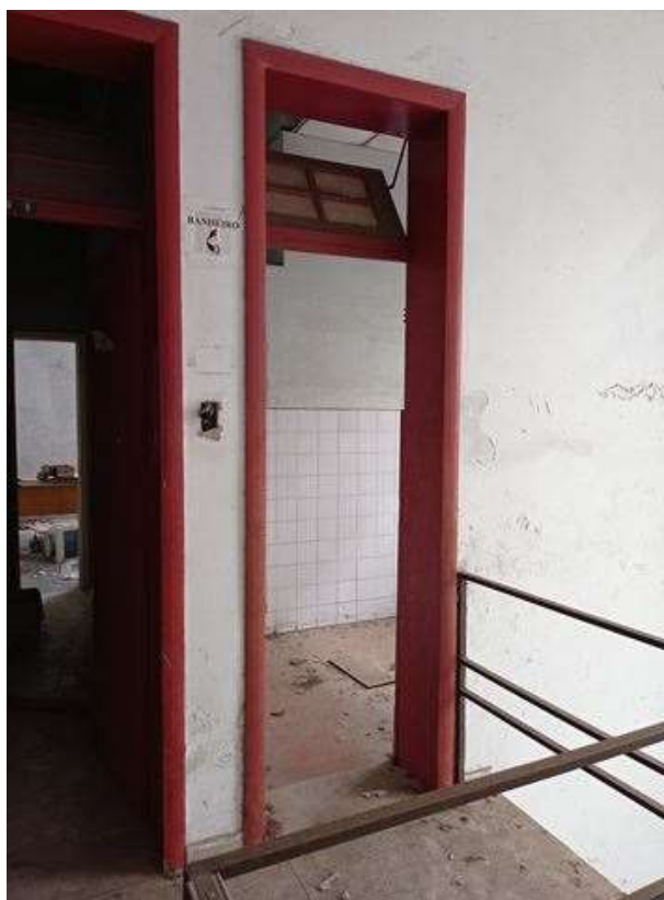
Figura 150: Porta PE13, localizada na circulação horizontal do segundo pavimento. Fonte: SCHARLAU, M.L (2022).
