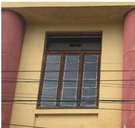
Figura 124: Janela de madeira com bandeira, três folhas e caixilhos com vidro. Localizada no segundo pavimento. Código JE1. Fonte: FROS, C.S (2022).
