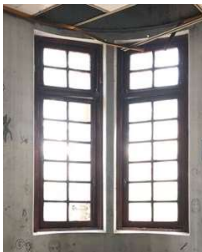
Figura 125: Janelas de madeira com bandeira, localizadas no vértice arredondado do segundo pavimento. Vista interna. Código JE3a e JE3b. Fonte: FROS, C.S (2022).
