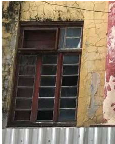
Figura 110: Janela de madeira com bandeirola, três folhas e caixilhos com vidro. Identificada em desenho técnico como JE1b. Voltada à Praça Saldanha Marinho, vê-se recorte em bandeirola, devido à instalação de ar-condicionado. Fonte: FROS, C.S (2022).
