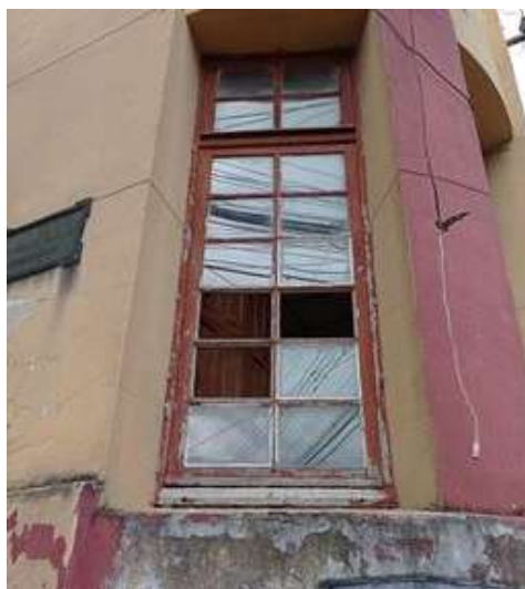
Figura 116: Janela JE2b, localizada no vértice da edificação – térreo. Fonte: SCHARLAU, M.L (2022).
