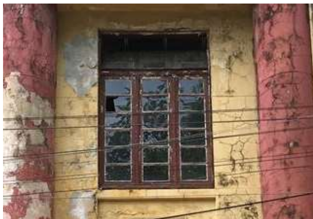
Figura 118: Janela de madeira com bandeiriola, três folhas e caixilhos com vidro. Localizada no segundo pavimento. Código JE1g. Fonte: FROS, C.S (2022).
