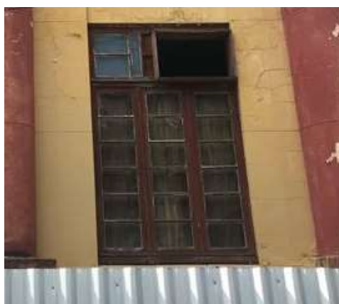
Figura 113: Janela de madeira com bandeira, três folhas e caixilhos com vidro. Identificada em desenho técnico como JE1e. Vê-se recorte em bandeira, devido à instalação de ar-condicionado.
