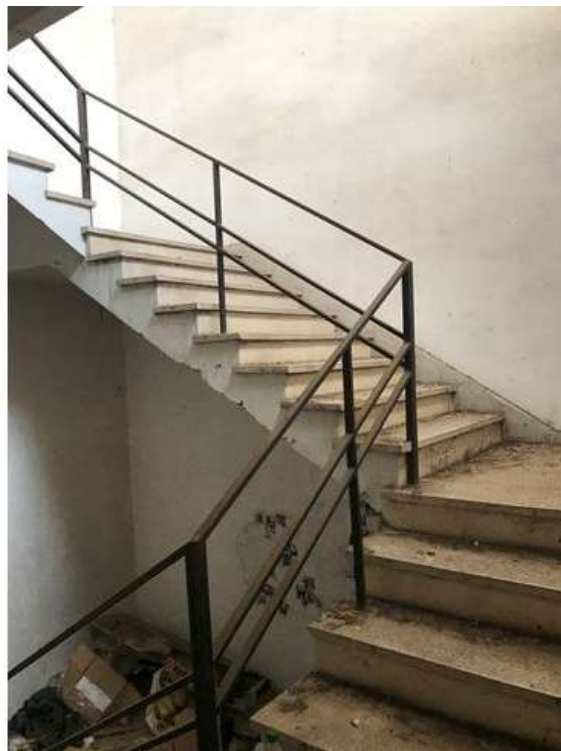
Figura 96: Continuidade da escada, direcionando ao quarto pavimento. Fonte: FROS, C.S (2022).
