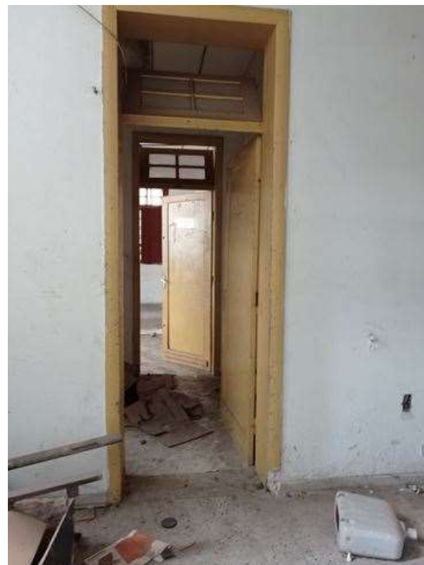
Figura 140: Porta PE7, localizada na circulação horizontal do primeiro pavimento. Fonte: SCHARLAU, M.L (2022).
