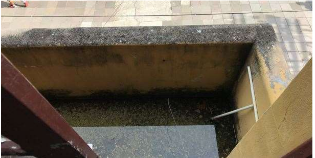
Figura 77: Sacada com saída/calha obstruída. Fonte: FROS, C.S (2022).
