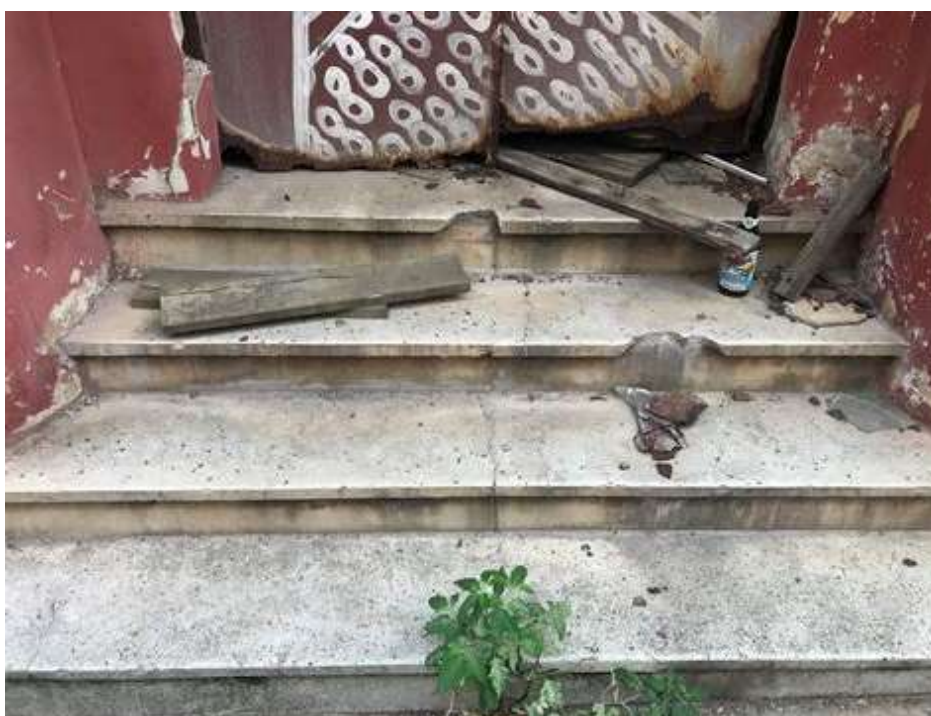
Figura 108: Escada de mármore, correspondente ao acesso lateral, localizado na Rua Roque Callage. Fonte: FROS, C.S (2022).
