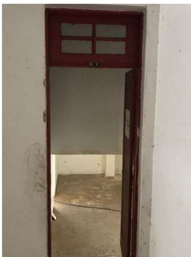
Figura 82: Acesso ao nível inferior do segundo pavimento. Fonte: FROS, C.S (2022).
