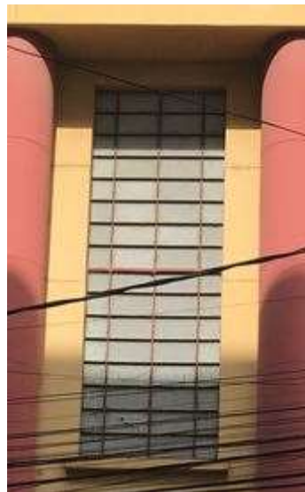
Figura 133: Janela JE12, localizada centralizada à fachada voltada à Rua Roque Callage. Fonte: FROS, C.S (2022).
