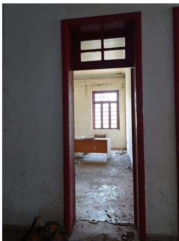
Figura 147: Porta PE9a, localizada na circulação horizontal do segundo pavimento. Fonte: SCHARLAU, M.L (2022).
