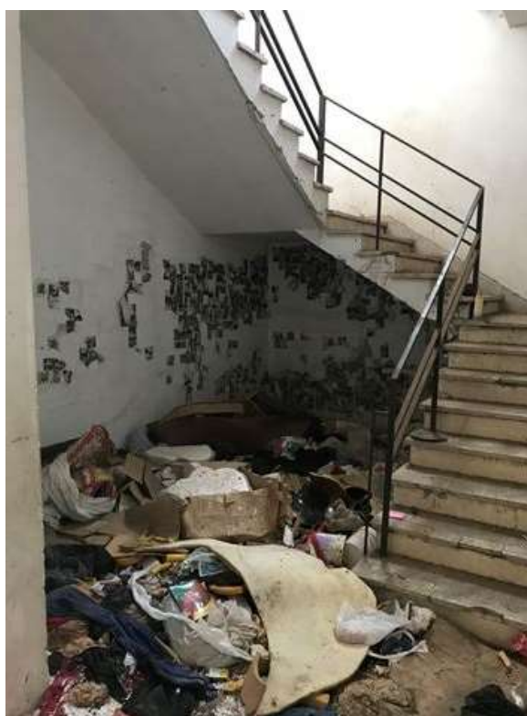
Figura 89: Escada que direciona ao terceiro e quarto pavimento. Fonte: FROS, C.S (2022).
