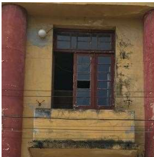
Figura 121: Porta de madeira com bandeirola, três folhas e caixilhos com vidro. Localizada no segundo pavimento, a imagem registrou a porta com uma folha aberta. Código PE17. Fonte: FROS, C.S (2022).
