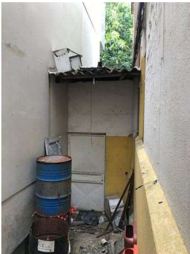
Figura 40: Porta de acesso lateral, localizada na fachada voltada ao Banrisul. Vista interna. Fonte: FROS, C.S (2022).
