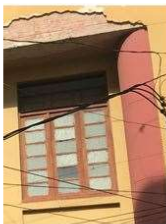
Figura 131: Janela JE4b, localizada no pavimento superior da fachada voltada à Rua Roque Callage. Fonte: FROS, C.S (2022).
